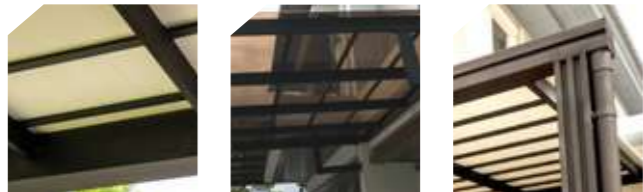
UPVC แบบวัสดุเนื้อหนา ท้องเรียบสวยงาม กระจกกรองแสง สี Charcoal โครงสร้างเหล็กพ่นสี 3 ชั้นตอน
