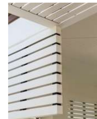
Outdoor Shading System บริการติดตั้งไม้ระแนง เมอรั สีสำเร็จ พร้อมโครงสร้างเหล็ก
