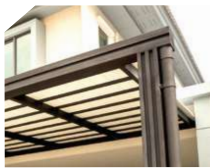
โครงสร้างเหล็ก ฟันสี 3 ชั้นตอน
