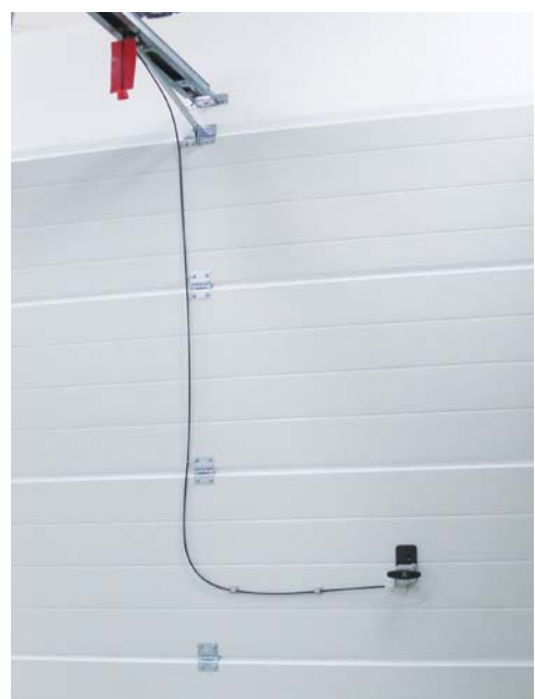
Interior handle with Bowden cable เปิดประตูจากด้านในด้วยสายสลิง
