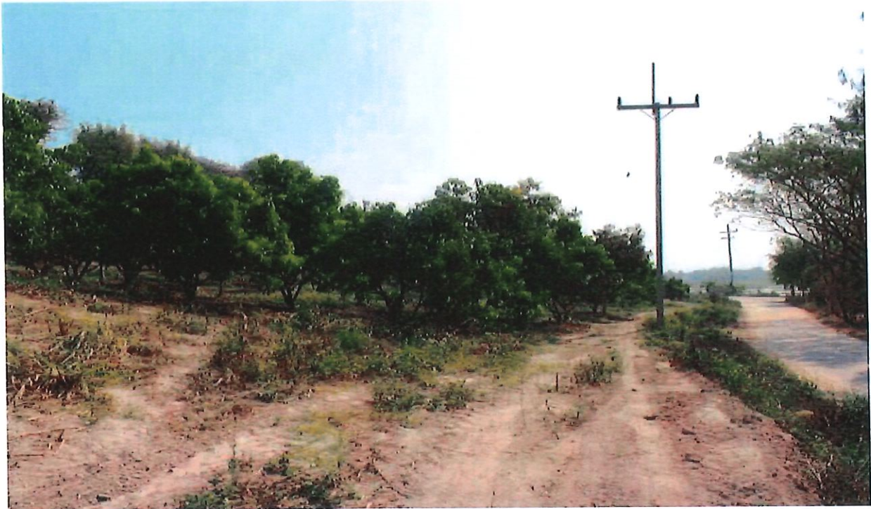
ภาพที่ 14. ที่ดินด้านเชิงเนินมีไฟฟ้าสามเฟสอยู่ริมถนน
