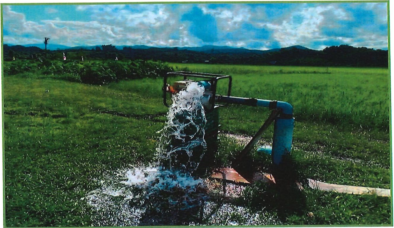
น้ำพุร้อนบ่อที่ 1 เจาะแล้วอุณหภูมิปากบ่อ 45 องศา PH 8.3
