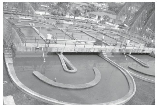
▲ รูปที่ 2 ตัวอย่างคลองวนเวียน สำหรับระบบบำบัดน้ำเสียชุมชนในประเทศไทย
