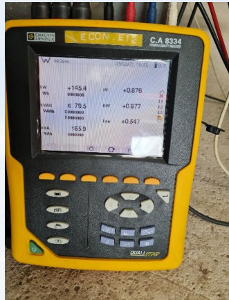
ภาพก่อนปรับปรุง
