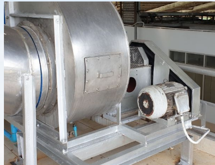
ภาพก่อนปรับปรุง
