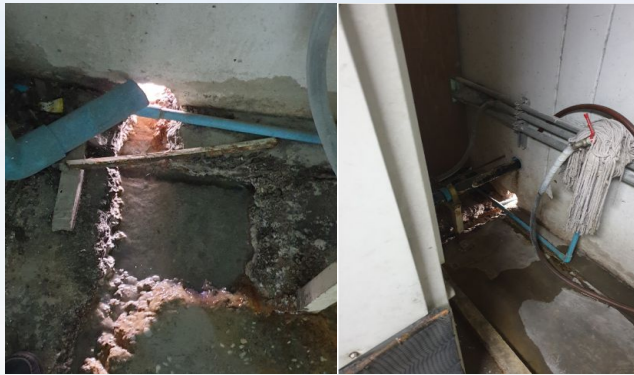
ภาพก่อนปรับปรุง
