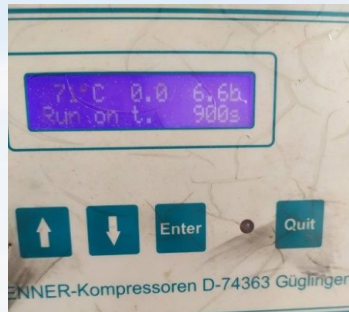
ภาพก่อนปรับปรุง
