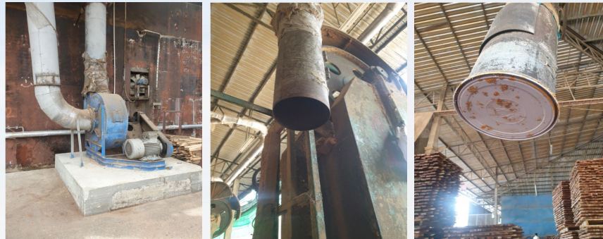
ภาพก่อนปรับปรุง
