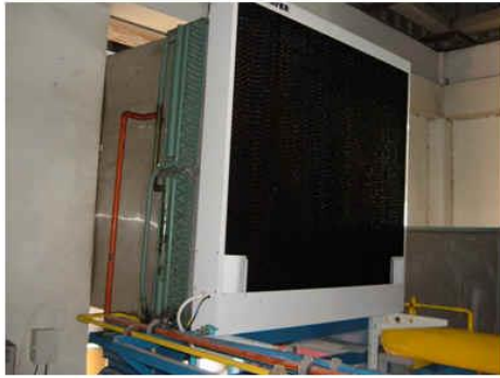
รูปที่ 6.15-15 อุณหภูมิอากาศที่ออกจาก Condenser ลดลงเป็น 40.9 °C ความชื้นที่ 47 %
