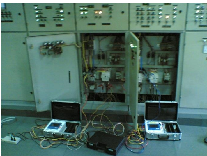
รูปที่ 6.15-3 การตรวจวัดระบบทำความเย็น
