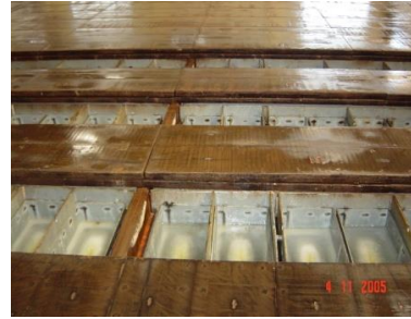
(ง) บ่อน้ำเกลือและอุปกรณ์แลกเปลี่ยนระหว่างแอมโมเนียและน้ำเกลือ
