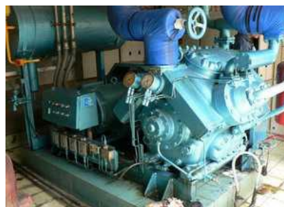
รูปที่ 6.13-2 เครื่องอัดสารทำความเย็นชุดที่เปลี่ยนใหม่
