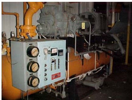
(ก) เครื่องอัดน้ำยาซึ่งส่วนใหญ่จะเป็นแบบสกปรู เนื่องจากราคาถูกกว่าแบบอื่นๆ
