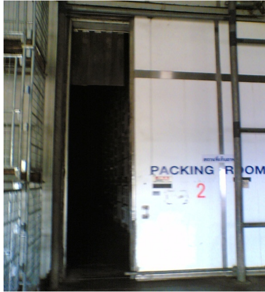
รูปที่ 6.15-2 ห้องเย็น
