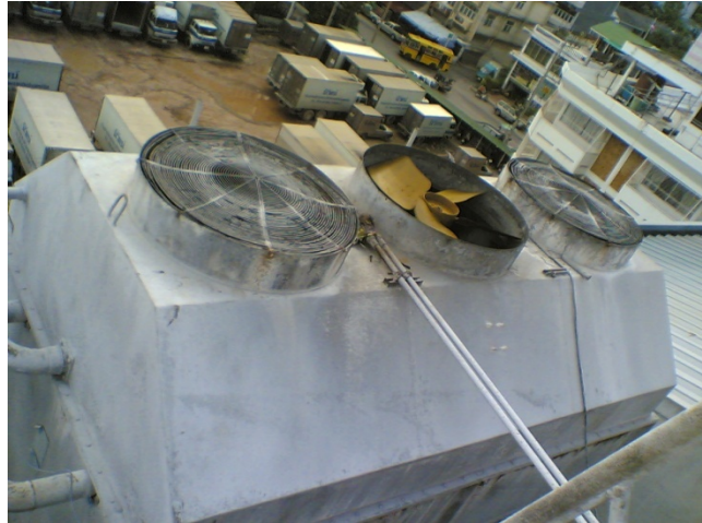
รูปที่ 6.15-5 ชุดพัดลมระบายความร้อนของระบบทำความเย็น No.2
