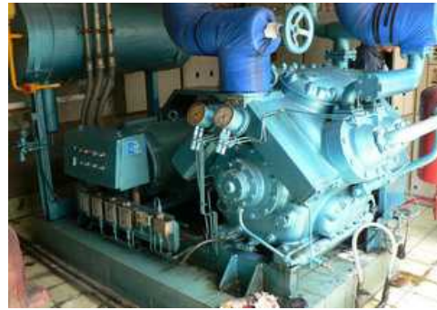
รูปเครื่องอัดสารทำความเย็นชุดที่เปลี่ยนใหม่
