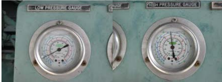
รูปที่ 6.15-12 การตรวจวัดอุณหภูมิและแรงดันสารทำความเย็น
