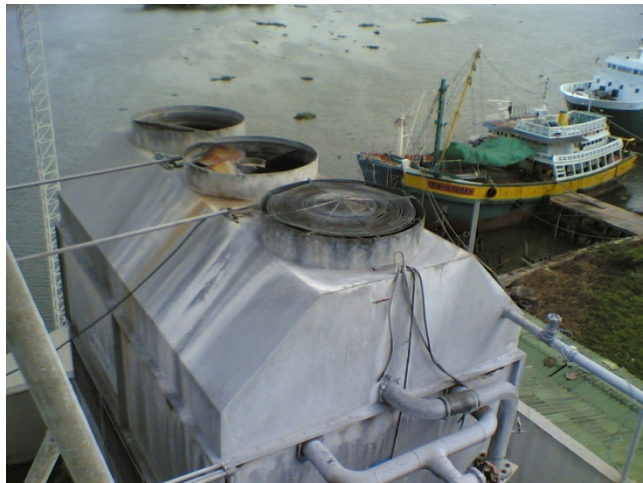
รูปที่ 6.15-4 ชุดพัดลมระบายความร้อนของระบบทำความเย็น No.1
