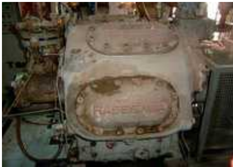
รูปเครื่องอัดสารทำความเย็นชุดที่จะเปลี่ยน
