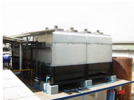
(ข) ชุดระบายความร้อนเพื่อควบแน่นน้ำยานิยมใช้หอระบายความร้อนที่ใช้น้ำกับอากาศระบายความร้อน ส่วนน้ำแข็งหลอดนิยมใช้ชุดระบายความร้อนแบบใช้น้ำระบายความร้อน
