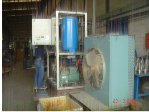
(ง) ชุดระบายความร้อนเพื่อควบแน่นน้ำยาโดยใช้อากาศ
