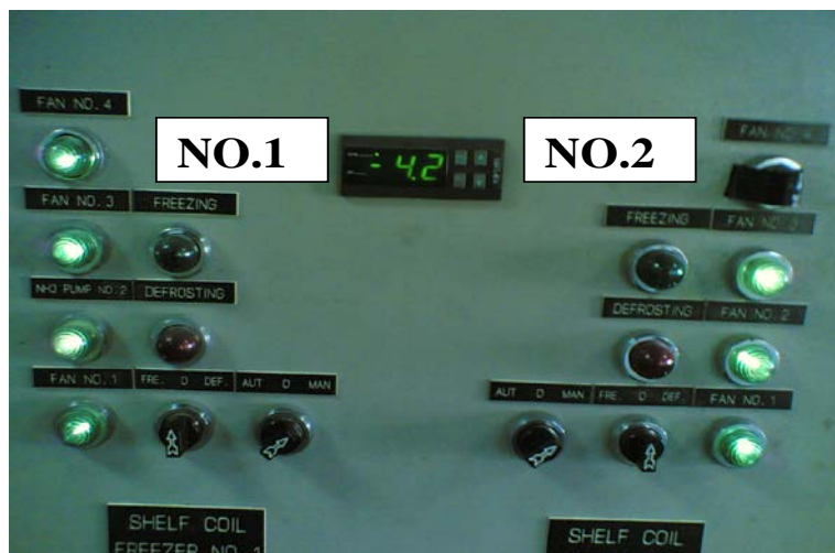
รูปที่ 6.15-6 การเปิดชุดพัดลมระบายความร้อนทั้ง 2 ชุด
