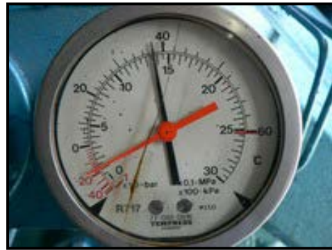
รูปความดันสารทำความเย็นด้านสูงใหม่
