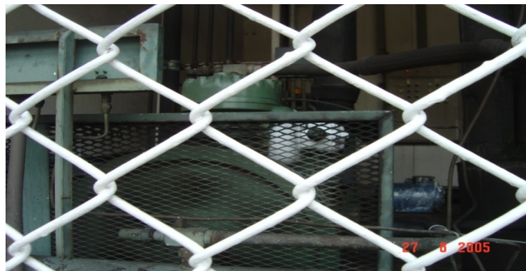
รูปที่ 6.15-8 COMPRESSOR ชุดที่ 1 ของห้องเย็นก่อนการปรับปรุงมีการเดินเครื่องตลอดเวลา
