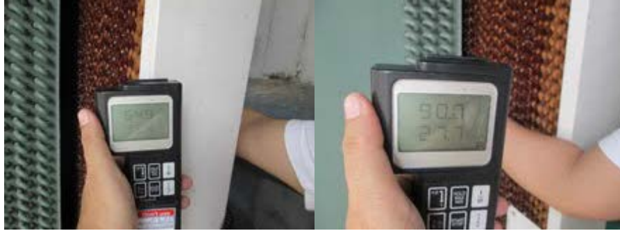
รูปที่ 6.15-11 การตรวจวัดอุณหภูมิเข้าและออกจาก Cooling Pad
