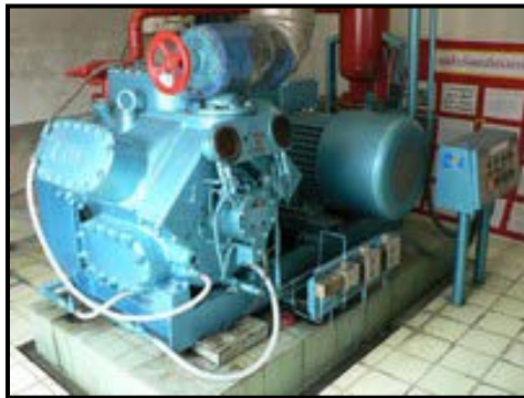
รูปความดันสารทำความเย็นด้านสูงเดิม
