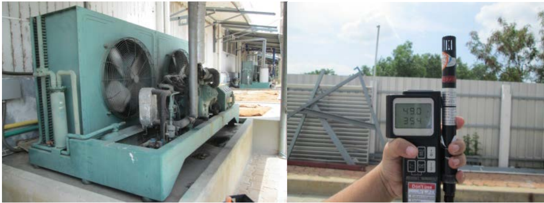
รูปที่ 6.15-9 เครื่องทำความเย็นและการตรวจวัดก่อนการปรับปรุง
