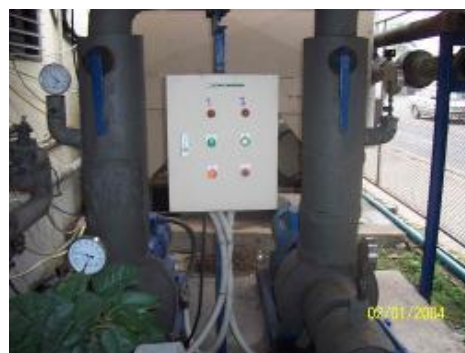
รูปที่ 5.11-2 แสดงการเดิน เครื่องทำน้ำเย็นและ ปั๊มน้ำเย็นอย่างละชุด
