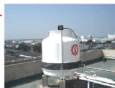
รูปที่ 5.11-31 ระบบหล่อเย็นที่ใช้งานในส่วนเครื่องทำน้ำเย็นและส่วนของ Evaporation (หลังปรับปรุง)
