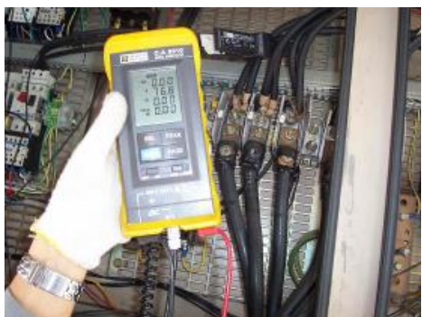
รูปที่ 5.11-1 เครื่องทำน้ำเย็นสำหรับปรับอากาศและการตรวจวัดค่ากระแสไฟฟ้า
