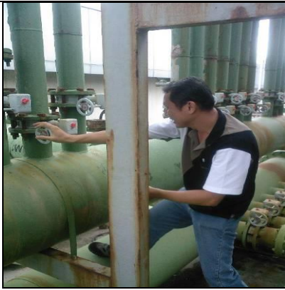
รูปที่ 5.11-12 ปรับวาล์วระบายความร้อนที่ header บริเวณหอระบายความร้อน
