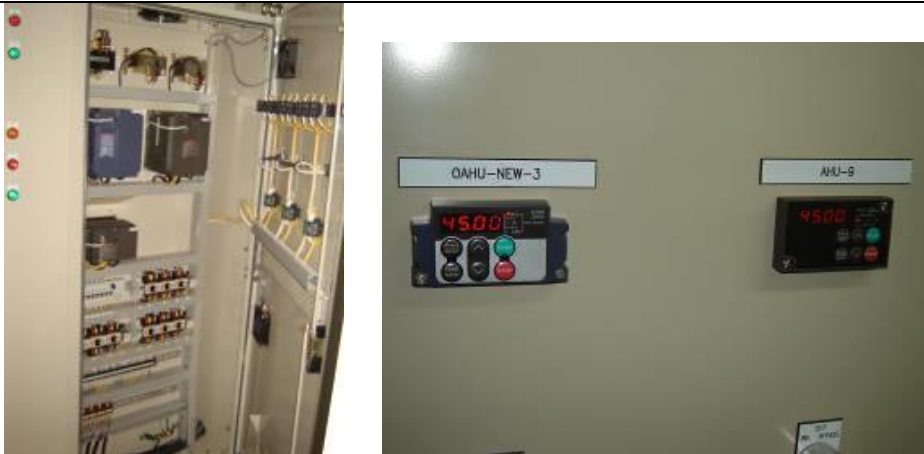
รูปที่ 5.11-41 ติดตั้ง Invertor และอุปกรณ์ควบคุม
