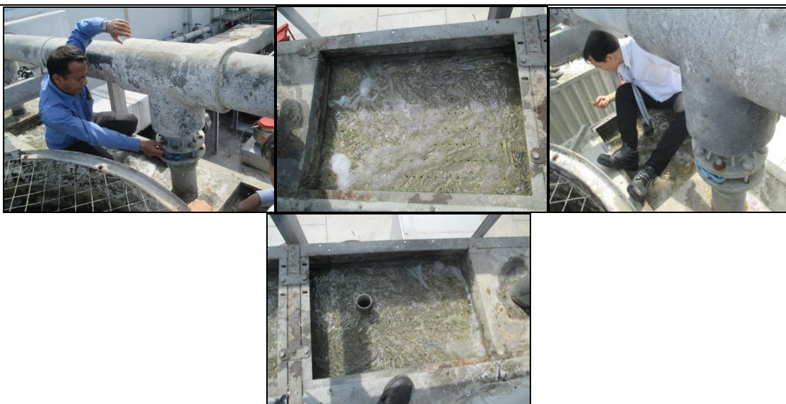
รูปที่ 5.11-39 CT ตอนสมดุลน้ำแล้ว
