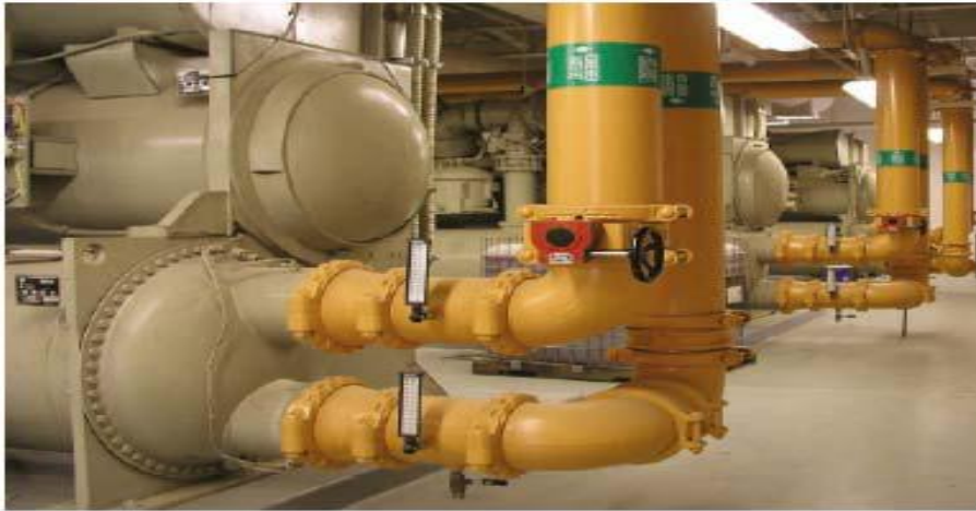
รูปที่ 5.12-37 เครื่องทำน้ำเย็นแบบปรับความเร็วรอบคอมเพรสเซอร์
