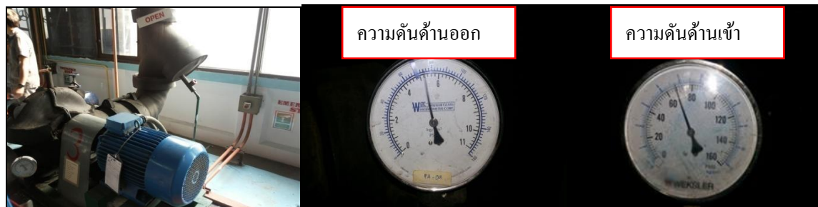
รูปที่ 5.11-33 ความดันน้ำเข้าและออกเครื่องสูบน้ำ
