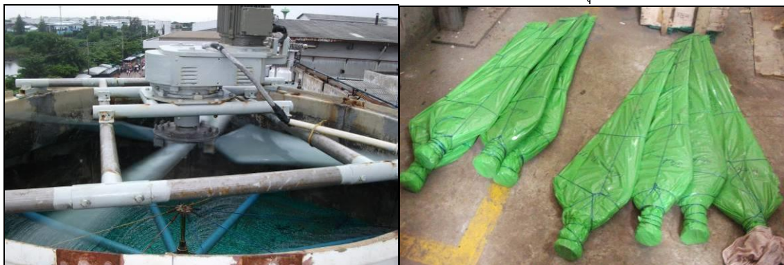
รูปที่ 5.11-26 ใบพัดลมไฟเบอร์ใหม่
