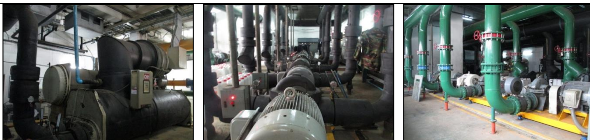
รูปที่ 5.11-34 เครื่องทำน้ำเย็น เครื่องสูบน้ำเย็น และเครื่องสูบน้ำระบายความร้อน
