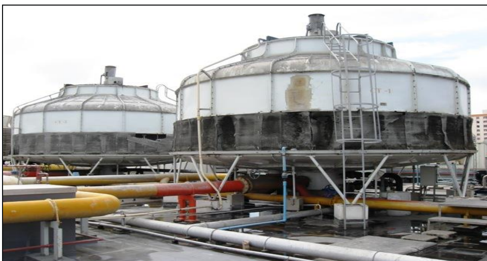
รูปที่ 5.11-27 Cooling Tower ตัวเก่า 1,2 ของโรงงาน
