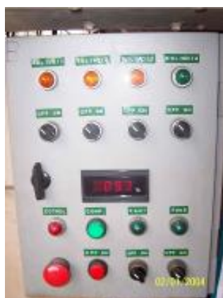
รูปที่ 5.11-3 ภาพการตั้งอุณหภูมิน้ำเย็นให้สูงขึ้น
