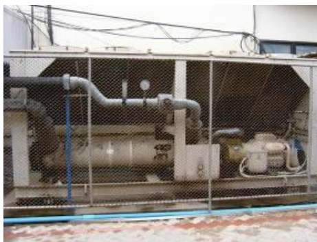
รูปที่ 5.11-1 เครื่องทำน้ำเย็นสำหรับปรับอากาศและการตรวจวัดค่ากระแสไฟฟ้า
