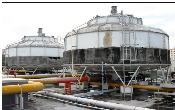
รูปที่ 5.11-27 Cooling Tower ตัวเก่า 1,2 ของโรงงาน
