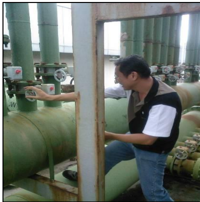
รูปที่ 5.11-12 ปรับวาล์วน้ำระบายความร้อนที่ header บริเวณหอระบายความร้อน
