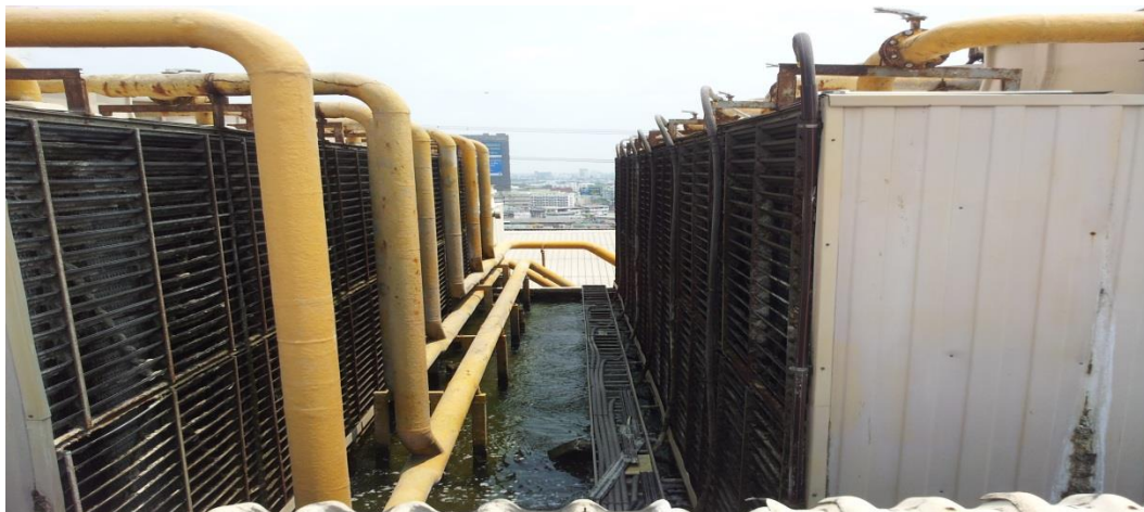
รูปที่ 5.11-40 บ่อน้ำออกจากหอบายความร้อน
