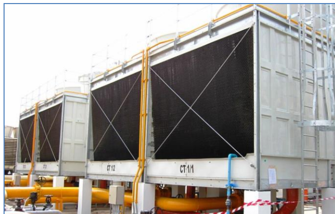
รูปที่ 5.11-28 Cooling Tower ตัวใหม่ที่โรงงานทำการติดตั้งแทนตัวเก่า
