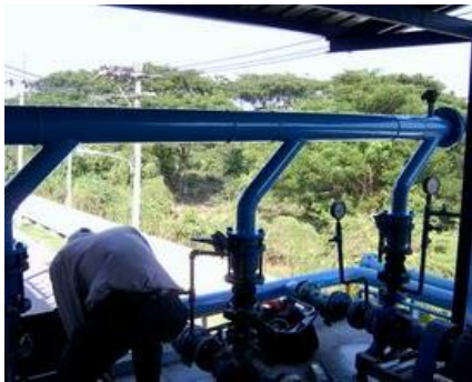
รูปที่ 5.11-24 การเชื่อมต่อท่อแบบตัววาย
