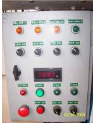
รูปที่ 5.11-3 ภาพการตั้งอุณหภูมิน้ำเย็นให้สูงขึ้น
