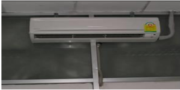
รูปที่ 5.11-10 เครื่องปรับอากาศชุดใหม่ หลังการปรับปรุง
