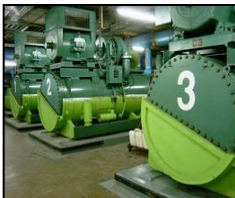
รูปความดันสารทำความเย็นและพลังไฟฟ้า ที่ใช้ก่อนทำความสะอาด
