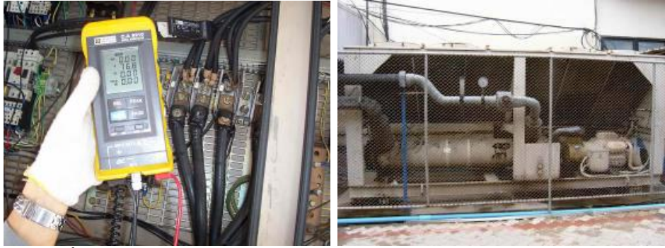
รูปที่ 5.11-1 เครื่องทำน้ำเย็นสำหรับปรับอากาศและการตรวจวัดค่ากระแสไฟฟ้า
