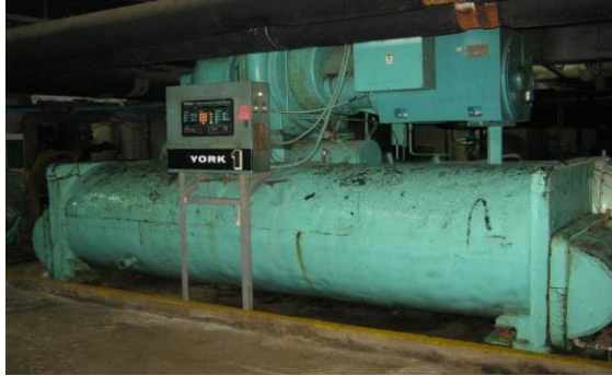
รูปที่ 5.11-19 เครื่องทำน้ำเย็นเดิมที่ใช้
