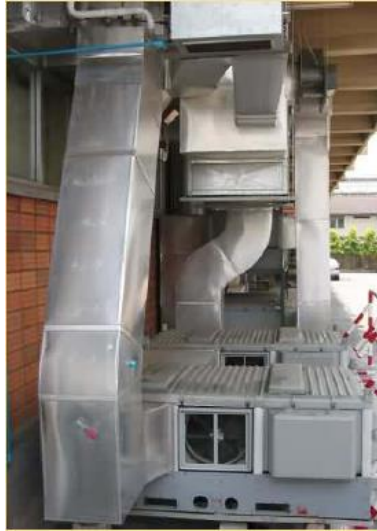
รูปที่ 5.12-11 ระบบลดความชื้นด้วยสารดูดความชื้นเหลวที่ติดตั้งในโรงงานผลิตยา (4)
