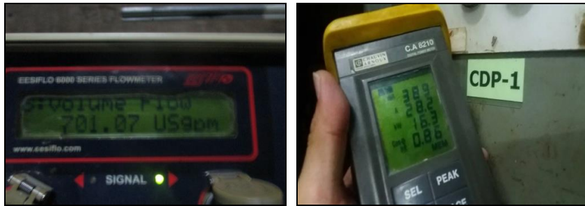
รูปที่ 5.11-37 อัตราการไหลและกำลังไฟฟ้า CDP-01 หลังปรับปรุง
