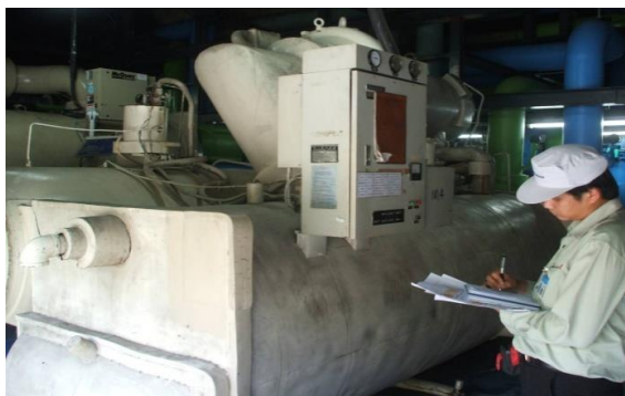
รูปที่ 5.11-16 Chiller No.4
