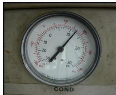
รูปที่ 5.11-14 ความดันสารทำความเย็นด้านสูงก่อนทำความสะอาด
