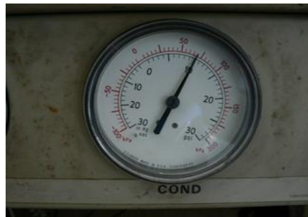
รูปที่ 5.11-15 ความดันสารทำความเย็นด้านสูงหลังทำความสะอาด
