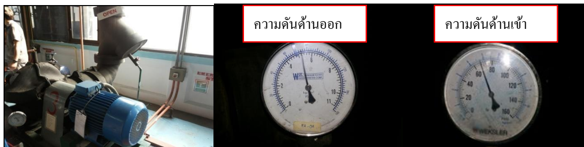
รูปที่ 5.11-33 ความดันน้ำเข้าและออกเครื่องสูบน้ำ
