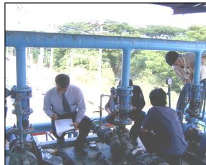
รูปที่ 5.11-23 การเชื่อมต่อท่อแบบตัวที
