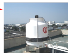
รูปที่ 5.11-31 ระบบหล่อเย็นที่ใช้งานในส่วนของเครื่องทำน้ำเย็นและส่วนของ Evaporation (หลังปรับปรุง)
