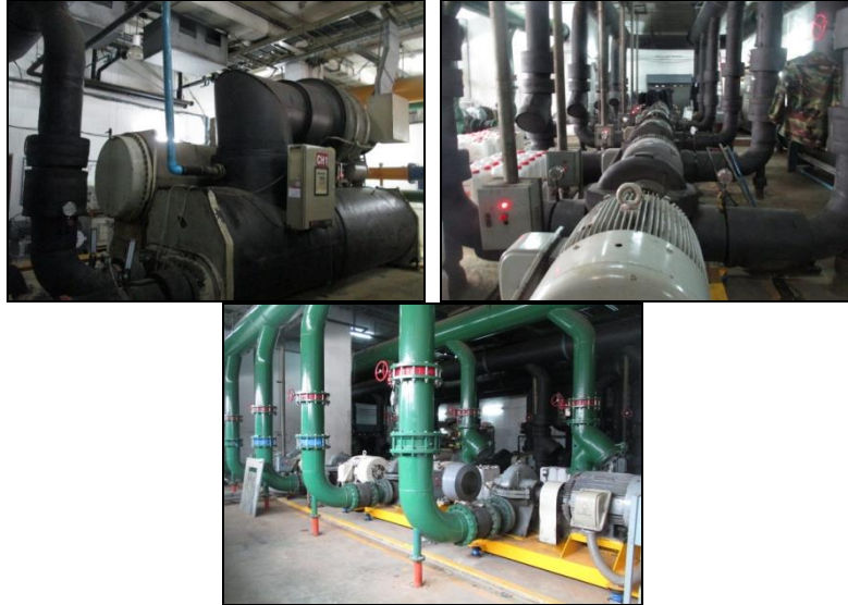
รูปที่ 5.11-34 เครื่องทำน้ำเย็น เครื่องสูบน้ำเย็น และเครื่องสูบน้ำระบายความร้อน
