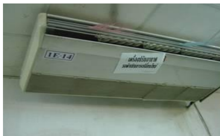
รูปที่ 5.11-9 เครื่องปรับอากาศชุดเดิม ก่อนการปรับปรุง
