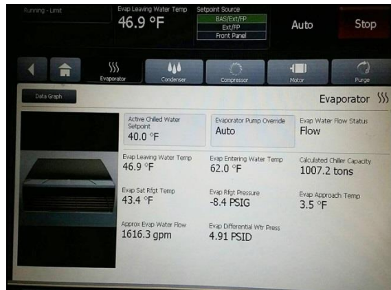
รูปที่ 5.11-35 การตรวจวัดเครื่องทำน้ำเย็น
