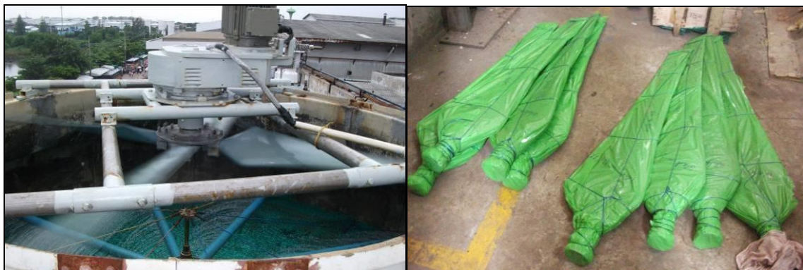
รูปที่ 5.11-26 ไขว้พัดลมไฟเบอร์ใหม่
