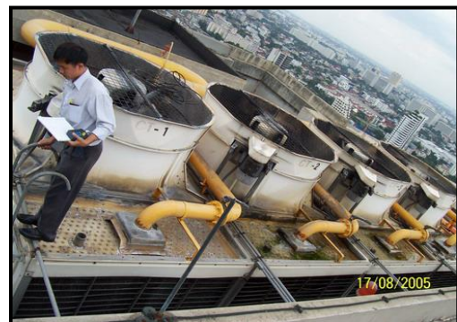
รูปอุณหภูมิน้ำระบายความร้อนที่เข้าคอนเดนเซอร์ และพลังไฟฟ้าของเครื่องทำน้ำเย็นหลังปรับปรุง
