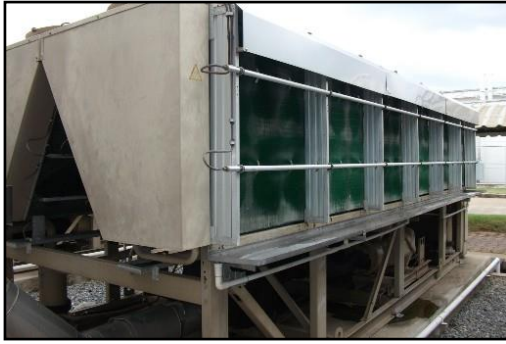
รูปที่ 5.11-17 Air Cooled Water Chiller 170 TR
