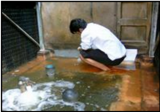
รูปอุณหภูมิน้ำระบายความร้อนที่เข้าคอนเดนเซอร์ และพลังไฟฟ้าของเครื่องทำน้ำเย็นก่อนปรับปรุง
