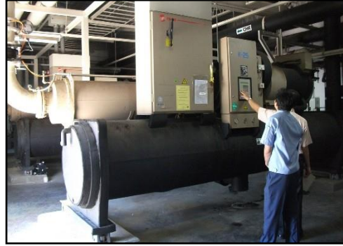
รูปที่ 5.11-18 Water Cooled Water Chiller 500 TR
