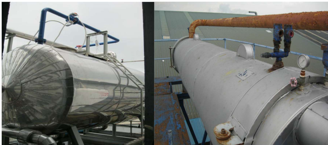
รูปที่ 4.8-8 Tank และ Heat Exchanger ที่ติดตั้ง
