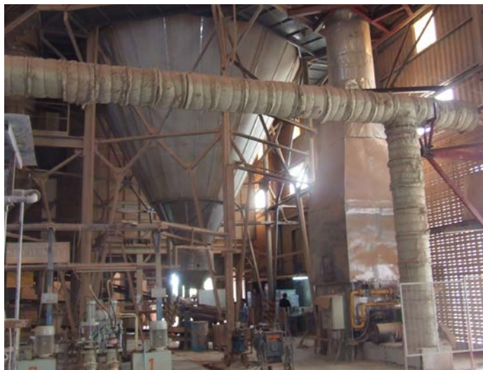
รูปที่ 4.8-2 หลังปรับปรุงนำอากาศร้อนจากการ Cooling แผ่นกระเบื้องผสมอากาศป้อนเข้าเผาไหม้ใน Spray Dryer
