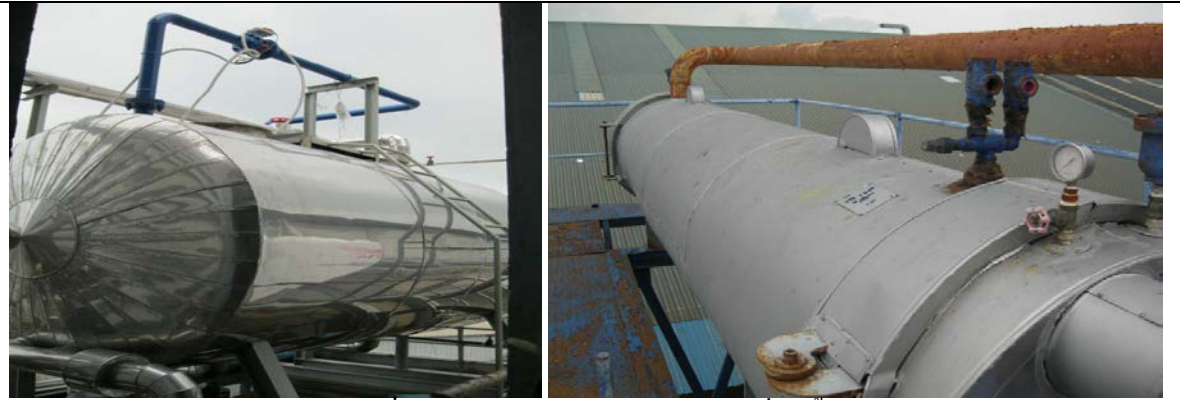
รูปที่ 4.8-8 Tank และ Heat Exchanger ที่ติดตั้ง
