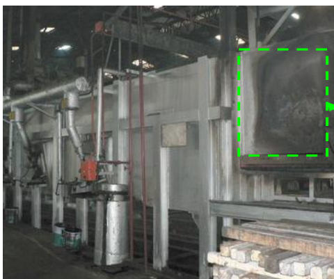
รูปผิวผนังก่อนหุ้มฉนวน
