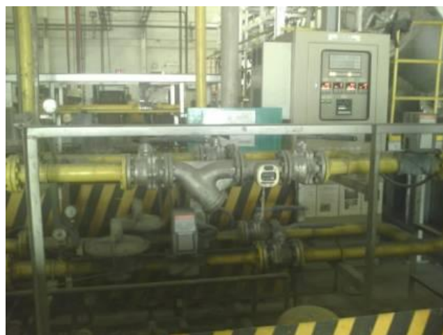
รูปที่ 3.8-12 มิเตอร์แก๊สที่ทางโรงงานใช้ในการเก็บข้อมูล
