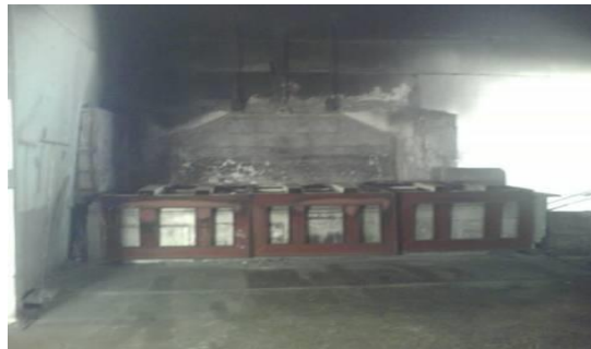
รูปที่ 3.8-9 ขณะทำการปรับปรุงปากเตาหลอม
