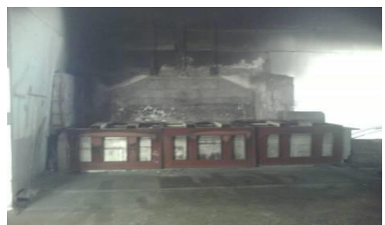
รูปที่ 3.8-11 หลังจากทำการปิดฝาครอบเตาหลอมแล้ว
