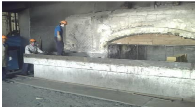
รูปที่ 3.8-9 ขณะทำการปรับปรุงปากเตาหลอม
