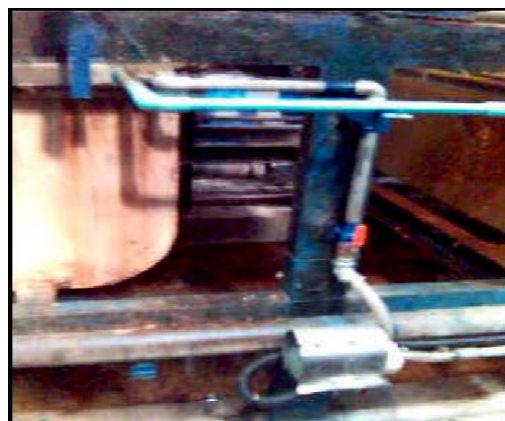
รูปที่ 2.12-17 ถังพักน้ำร้อนและเครื่องสูบน้ำกลับจากบ่อที่ 7 ไปยังบ่อที่ 5
