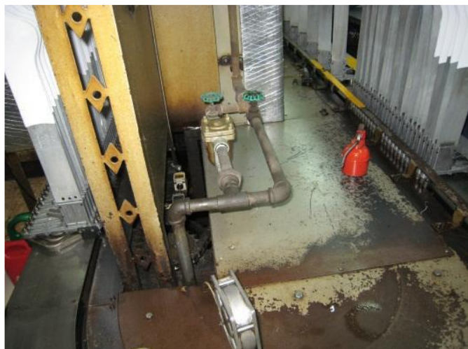
รูปกับดักไอน้ำชุดที่ปรับปรุง
