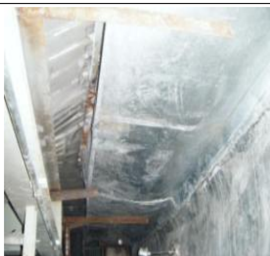
รูปที่ 2.12-9 หม้อไอน้ำหลังทำการซ่อมรอยรั่ว
