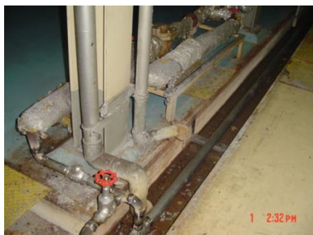
ตำแหน่งเชื่อมต่อท่อน้ำคอนเดนเสทเดิม
