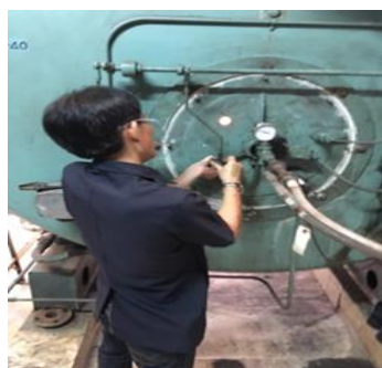
รูปที่ 2.12-11 ทำการปรับตั้งอัตราส่วนอากาศต่อเชื้อเพลิง
