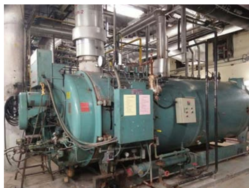
รูปที่ 12.2-23 หม้อไอน้ำที่ลดเวลาการใช้งาน
