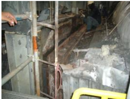
รูปที่ 2.12-7 ขณะทำการซ่อมบำรุงหม้อไอน้ำ
