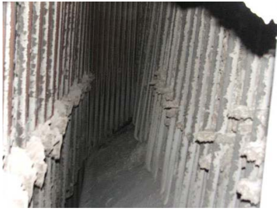
รูปที่ 2.12-5 ตะกรันที่จับที่ท่อไอน้ำก่อนทำความสะอาด
