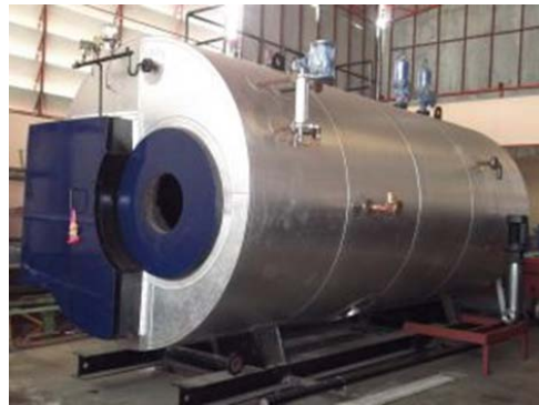
รูปที่ 12.2-20 หม้อไอน้ำที่ติดตั้งใหม่
