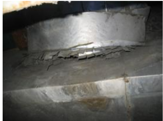
รูปที่ 2.12-6 รอยร้าวของหม้อไอน้ำก่อนปรับปรุง
