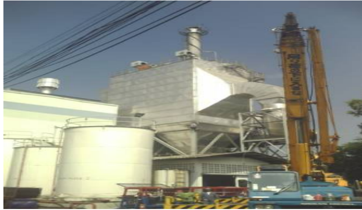
รูป 2.12-3 หม้อไอน้ำของทางโรงงาน
