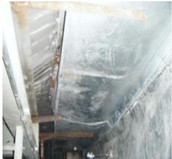
รูปที่ 2.12-9 หม้อไอน้ำหลังทำการซ่อมรอยรั่ว
