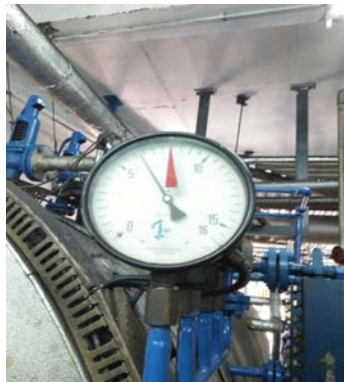
รูปที่ 12.2-22 ความดันไอน้ำหลังลดลง 1 Barg
