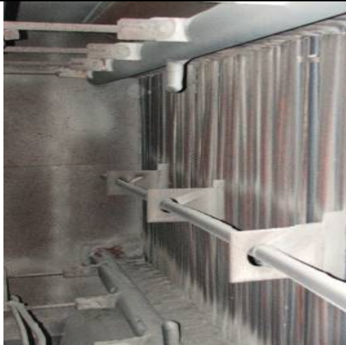
รูปที่ 2.12-8 ท่อไอน้ำหลังทำความสะอาด
