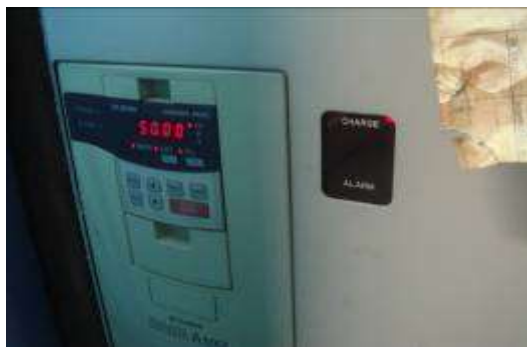
รูปที่ 7.12-9 อินเวอร์เตอร์และมอเตอร์พัดลมดูดอากาศในห้องพ่นสี
