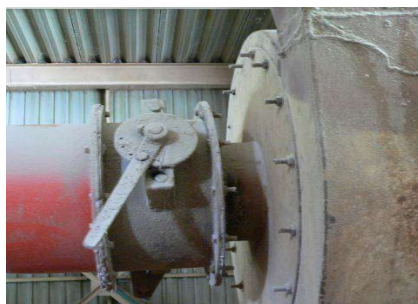
รูปที่ 7.12-2 แสดงการหรี Dampers และ Pulley เดิมของพัดลมเครื่องบด Jacobson
