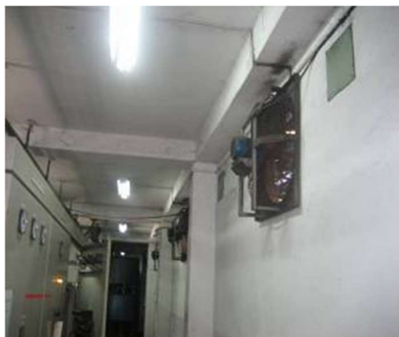
รูปที่ 7.12-14 พัดลมระบายความร้อนในห้องหม้อแปลง
