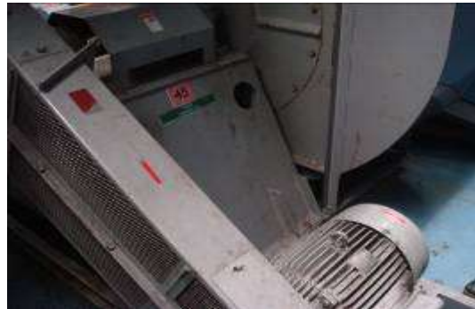
รูปที่ 7.12-9 อินเวอร์เตอร์และมอเตอร์พัดลมดูดอากาศในห้องพ่นสี
