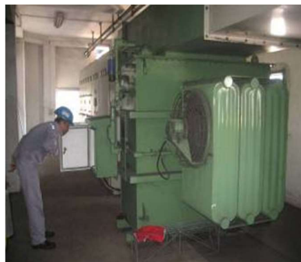
รูปที่ 7.12-14 พัดลมระบายความร้อนในห้องหม้อแปลง
