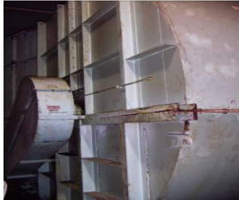
รูปที่ 7.12-7 แสดงมอเตอร์พัดลมระบายอากาศ
