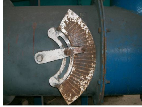
รูปที่ 7.12-3 พัดลมเป่าทรายและการปรับหรีดแอมเปอร์ ก่อนลดขนาดใบพัด
