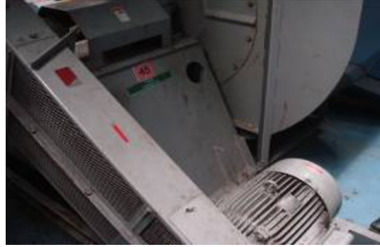
รูปที่ 7.12-9 อินเวอร์เตอร์และมอเตอร์พัดลมดูดอากาศในห้องพนัสนี
