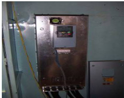
รูปที่ 7.12-8 แสดงการติดตั้งอุปกรณ์ควบคุมความเร็วรอบที่มอเตอร์พัดลมระบายอากาศ
