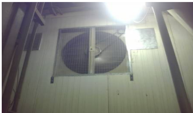
รูปที่ 7.12-11 การติดตั้งพัดลม axial fan หลังดำเนินการ
