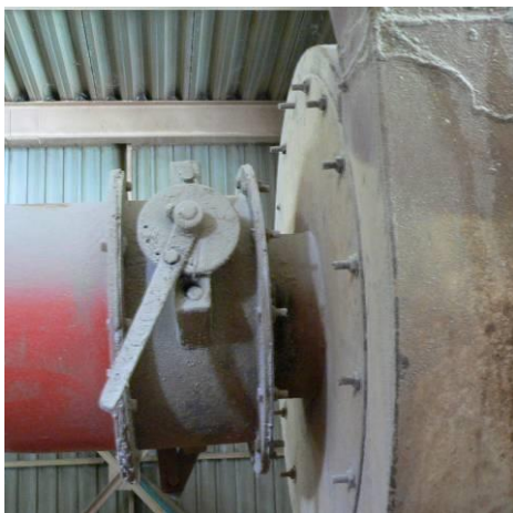
รูปที่ 6-26 แสดงการหรี Damper และ Pulley เดิมของพัดลมเครื่องบด Jacobson
