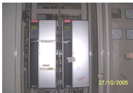
รูปที่ 6.12-10 การติดตั้งอุปกรณ์ลดรอบมอเตอร์ขับเคลื่อนเครื่องสูบน้ำหลังปรับปรุง
