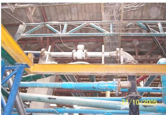
รูปที่ 6.12-10 การติดตั้งอุปกรณ์ลดรอบมอเตอร์ขับเคลื่อนเครื่องสูบน้ำหลังปรับปรุง
