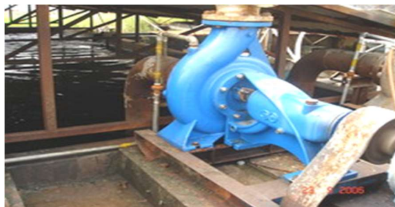
รูปที่ 6.12-3 เครื่องสูบน้ำระบายความร้อนหลังปรับปรุง
