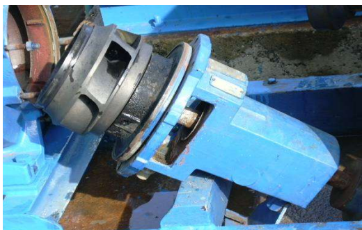
รูปที่ 6.12-11 แสดงใบพัดเครื่องสูบน้ำขนาด 19.8 ซม ก่อนปรับปรุง
