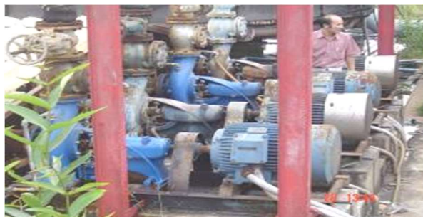
รูปที่ 6.12-3 เครื่องสูบน้ำระบายความร้อนหลังปรับปรุง
