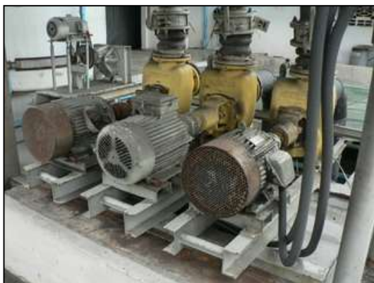
รูปที่ 6.11-21 ปั๊มน้ำและมอเตอร์ไฟฟ้าที่ใช้ในระบบบำบัดน้ำเสีย
