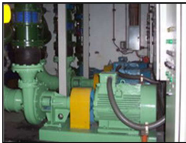
รูปที่ 6.11-4 เครื่องสูบน้ำที่ปรับความเร็วรอบ
