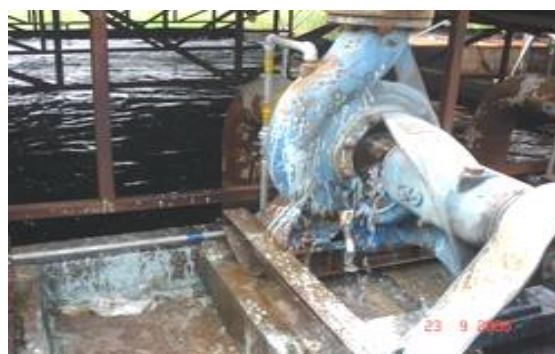
รูปที่ 6.12-2 เครื่องสูบน้ำระบายความร้อนที่มีน้ำรั่ว
