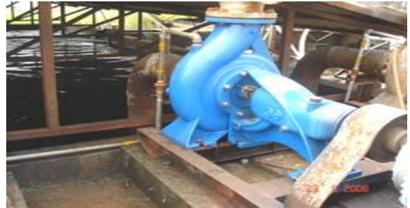
รูปที่ 6.12-3 เครื่องสูบน้ำระบายความร้อนหลังปรับปรุง
