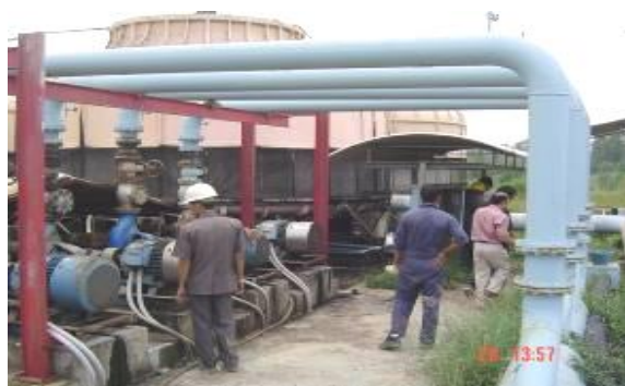
รูปที่ 6.12-2 เครื่องสูบน้ำระบายความร้อนที่มีน้ำรั่ว
