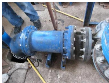
รูปแสดงปั๊มน้ำและท่อเหล็กที่ชำรุด
