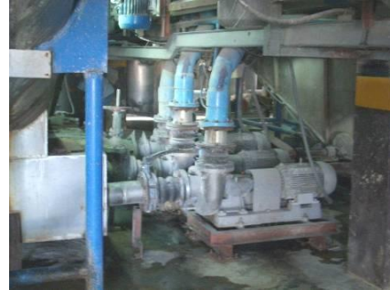
ภาพก่อนปรับปรุงของมอเตอร์ปั๊มน้ำกากของเสีย
