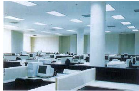
รูปที่ 3-27 ลักษณะของการกระจายแสงสว่างของดวงโคมแบบกระจายแสงสว่างลงด้านล่าง (Direct Luminaire)
