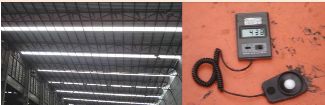
รูปที่ 3.14-13 ระดับความเข้มแสงสว่างหลังการปรับปรุงแผ่นหลังคาแบบโปร่งแสง
