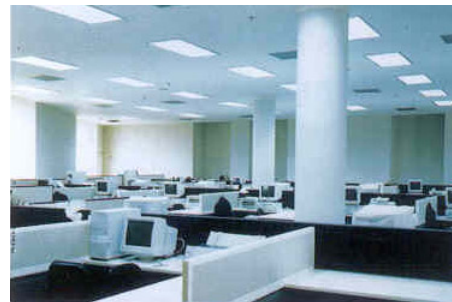
รูปที่ 3.6-11 ลักษณะการกระจายแสงสว่างของดวงโคมแบบกระจายแสงสว่างลงด้านล่าง (Direct Luminaire)
