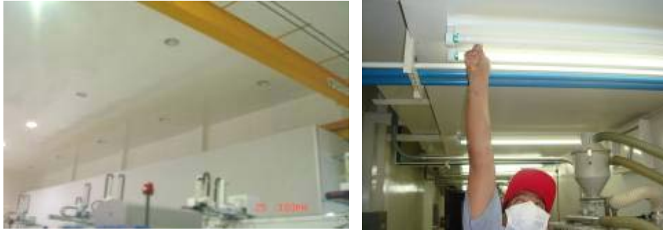
รูปที่ 3.14- 9 หลอดแสงจันทร์และหลอดฟลูออเรสเซนต์ที่ยกเลิกการใช้งาน
