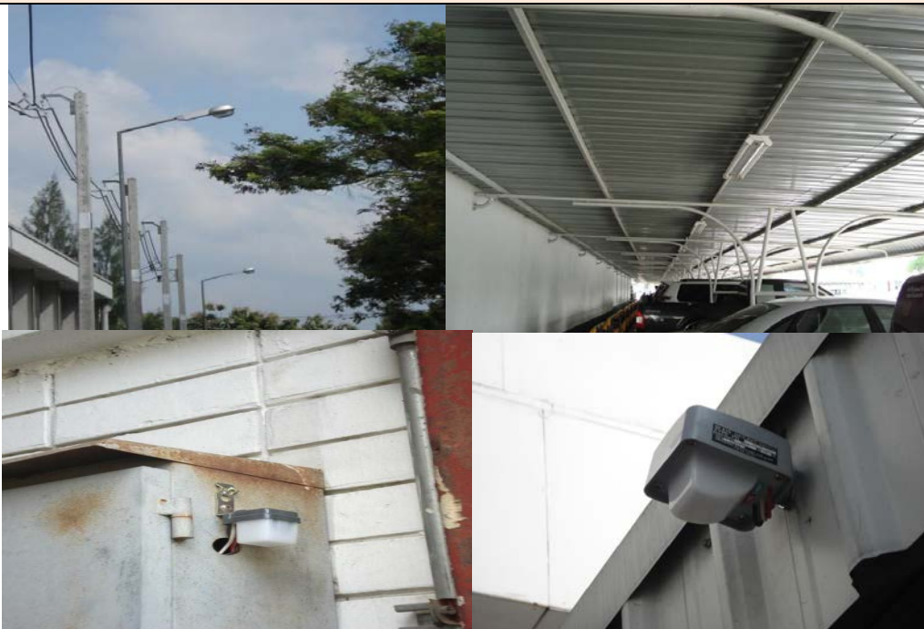
รูปที่ 3.14-14 การติดตั้ง Photo Switch เพื่อควบคุมแสงสว่างภายนอกอาคาร
