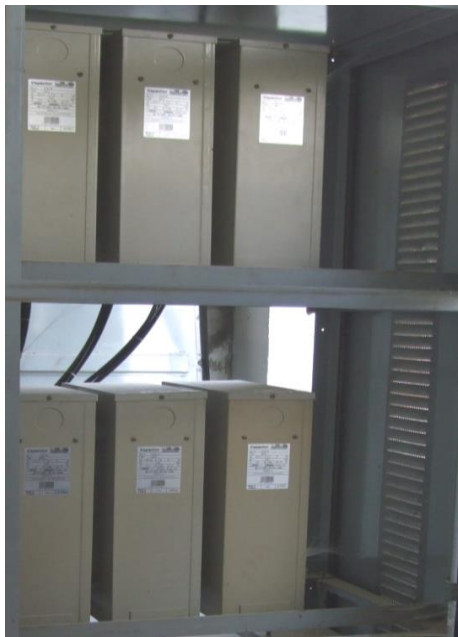
รูปที่ 2-14 Capacitor Bank หรือ Cap Bank
