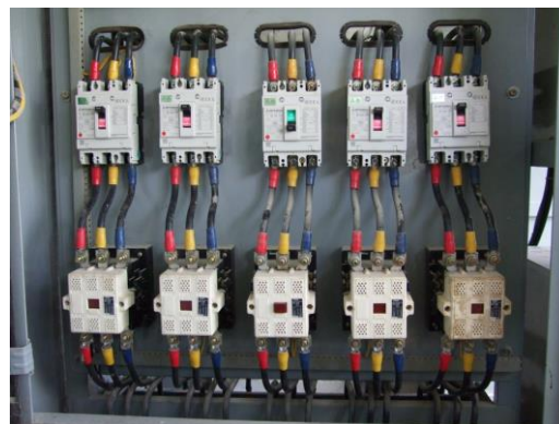
รูปที่ 2-14 Capacitor Bank หรือ Cap Bank
