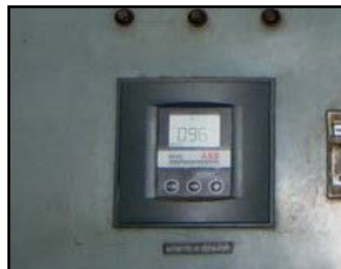
รูปค่าตัวประกอบกำลังไฟฟ้าหลังปรับปรุง
