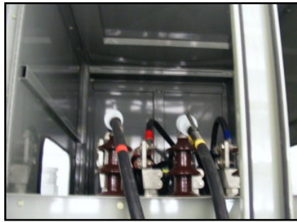
รูปที่ 2.11-4 แสดงตำแหน่งที่จะปรับแรงดันไฟฟ้า
