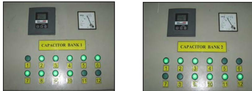
รูปที่ 2.11-2 แสดงค่าตัวประกอบกำลังไฟฟ้าหลังปรับปรุง
