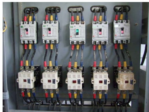
รูปที่ 2.4-3 Power Factor Controller และอุปกรณ์ตัดต่อ Cap Bank
