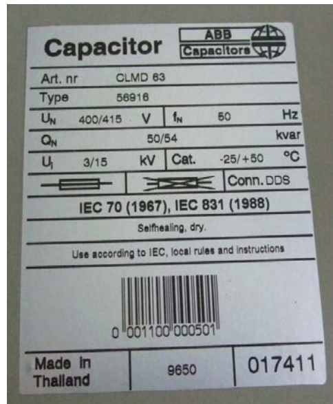
รูปที่ 2.4-2 Capacitor Bank หรือ Cap Bank
