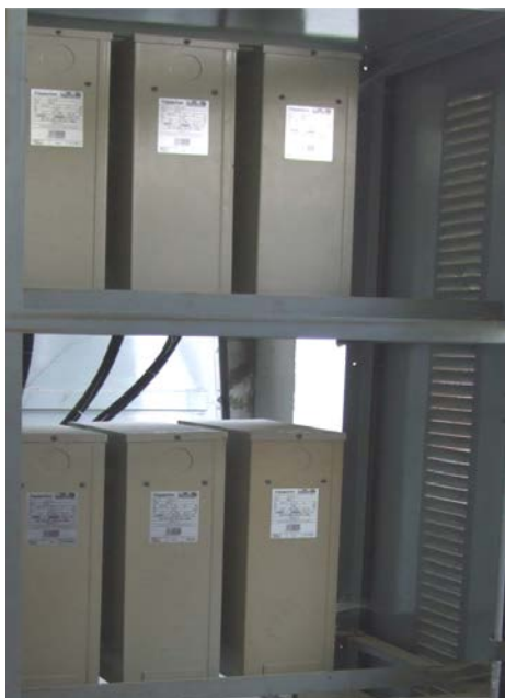
รูปที่ 2.4-2 Capacitor Bank หรือ Cap Bank
