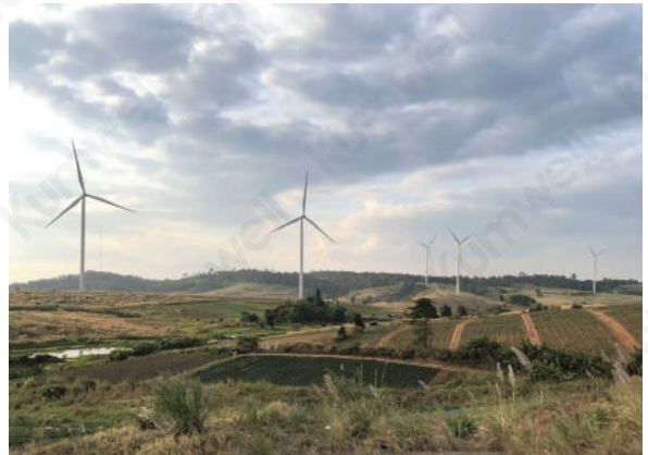
THAILAND : เสาค้ำ Wind Turbine
