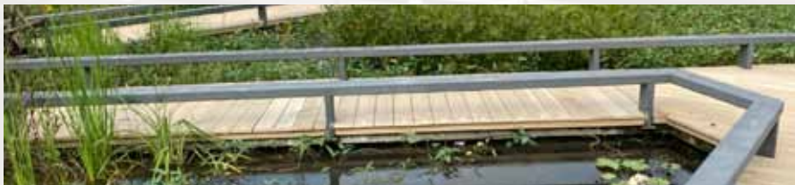
(2) ARTO EXTERIOR: วัสดุทดแทนไม้จริง ผลิตจาก WOOD POLYMER COMPOSITE (WPC)
