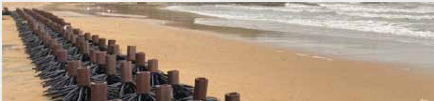
(1) C-AOS: CAPSULE-ARTO OCEAN SEDIMENT อุปกรณ์ควบคุมการกัดเซาะชายหาด
