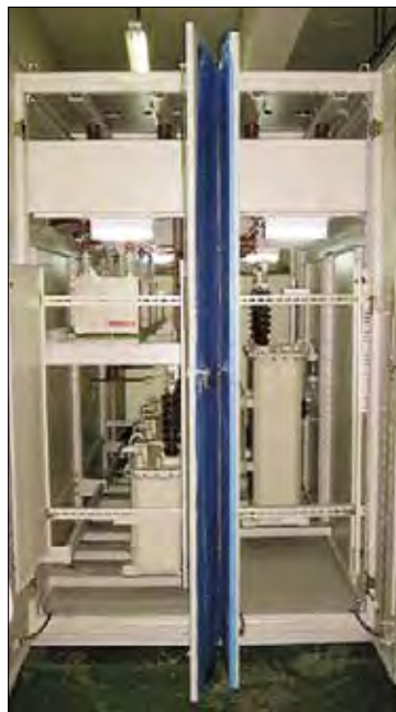
《《10kV 3P 50Hz 700kvar》》
