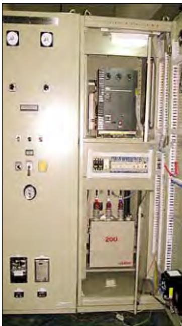
《《3.3kV 3P 50Hz 300kvar》》
