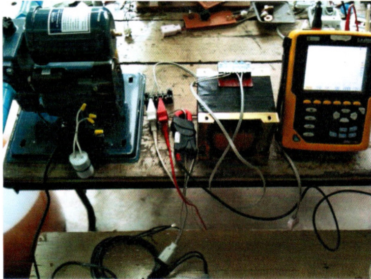
ภาพที่1 การติดตั้งเครื่องมือวัดก่อนติดตั้งอุปกรณ์ ULTRA รุ่น U-801
