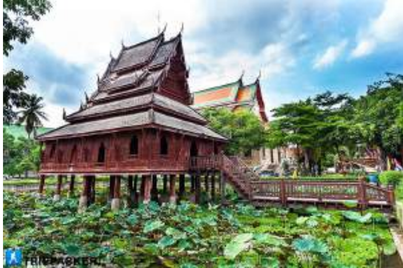
รูปภาพ ๑๘ หอไตรกลางสายธาร วัดทุ่งศรีเมือง อุบลราชธานี ศิลปะภาคอีสาน ป้องกันปลวก มด แมลง ที่มา : https://www.isangate.com/ (๒๓ กรกฎาคม ๒๕๖๖)
