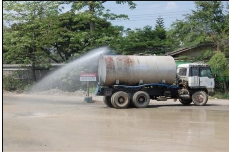
รูปที่ 5.2.4-1 ตัวอย่างการฉีดพรมน้ำเพื่อลดการฟุ้งกระจายของฝุ่นละออง
