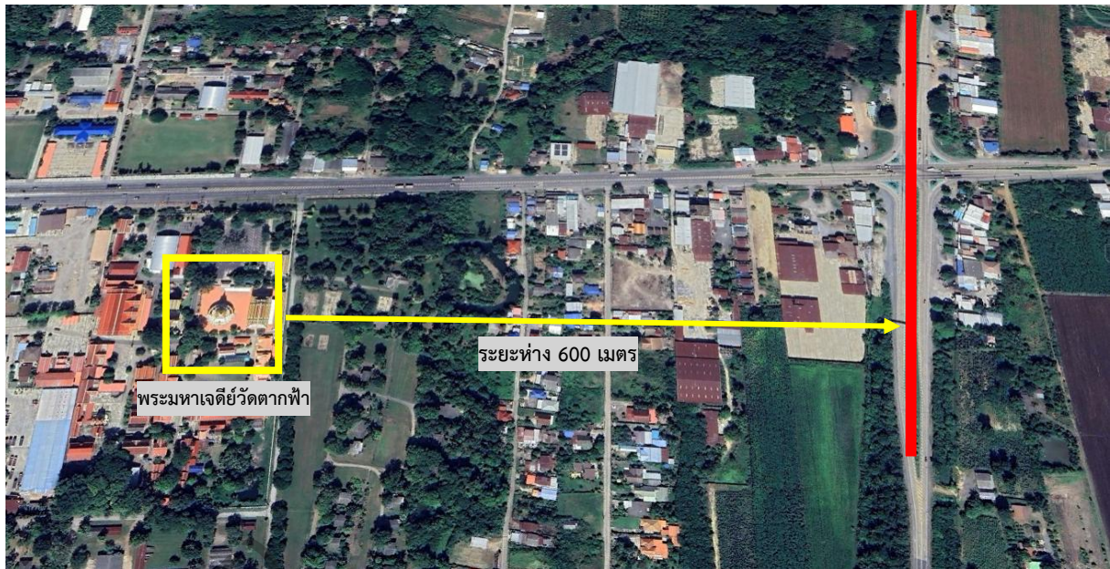
รูปที่ 4.4.10-3 การบดบังทัศนียภาพบริเวณพระมหาเจดีย์วัดตากฟ้า พระอารามหลวง มองไปยังโครงสร้างสะพานยกระดับจุดตัดทางหลวงหมายเลข 1 (แยกตากฟ้า)
