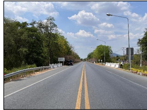
ลำรางสาธารณะ (กม.38+922)
