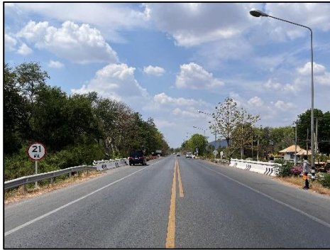
ลำรางสาธารณะ (กม.38+814)
