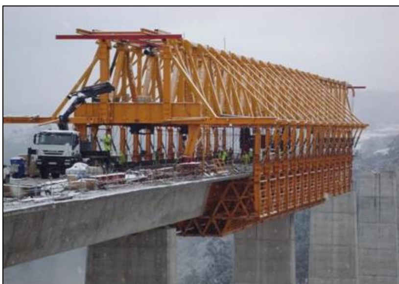
รูปที่ 5-22 วิธีก่อสร้างสะพานคานคอนกรีตรูปกล่องหล่อในที่ ด้วย Movable Scaffolding System
