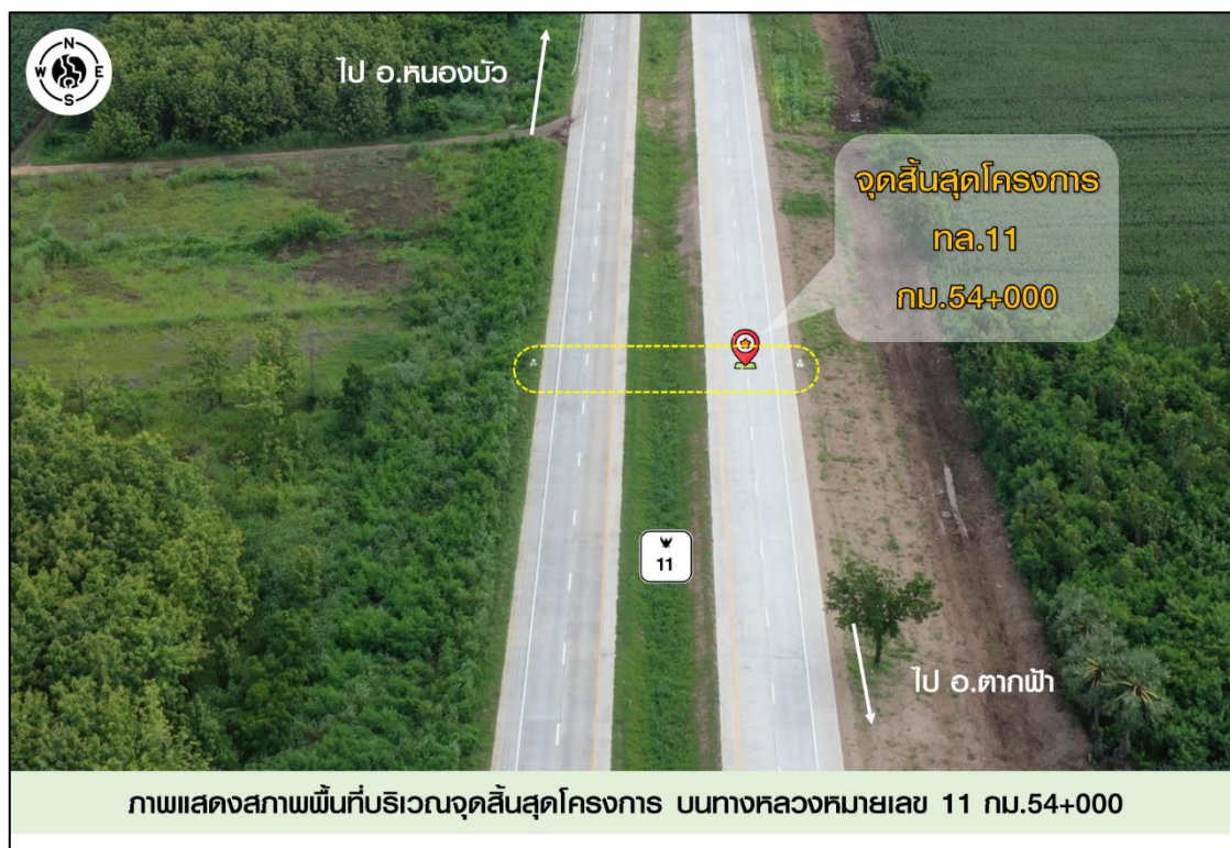
รูปที่ 4-4 ภาพถ่ายจากการบินโดรนภาพแสดงสภาพพื้นที่บริเวณจุดสิ้นสุดโครงการ บนทางหลวงหมายเลข 11 กม.54+000
