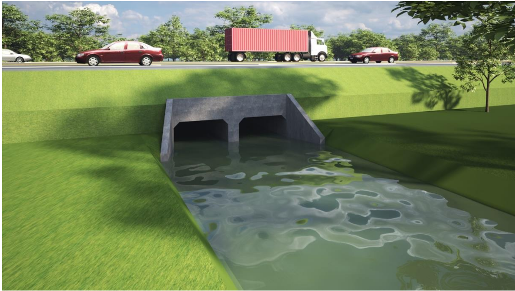
รูปที่ 5-33 ท่อระบายน้ำคอนกรีตแบบเหลี่ยม
