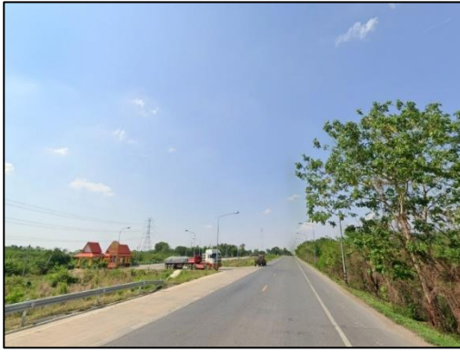
กม.48+000 จุดพักรถบรรทุก
