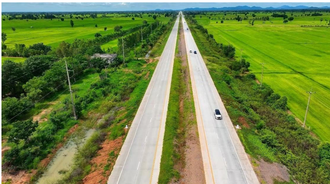
รูปที่ 5-13 ตัวอย่างผิวจราจรคอนกรีต
