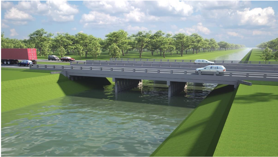
รูปที่ 5-31 สะพานคอนกรีตเสริมเหล็ก
