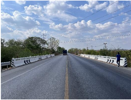
คลองหอม (กม.34+196)
