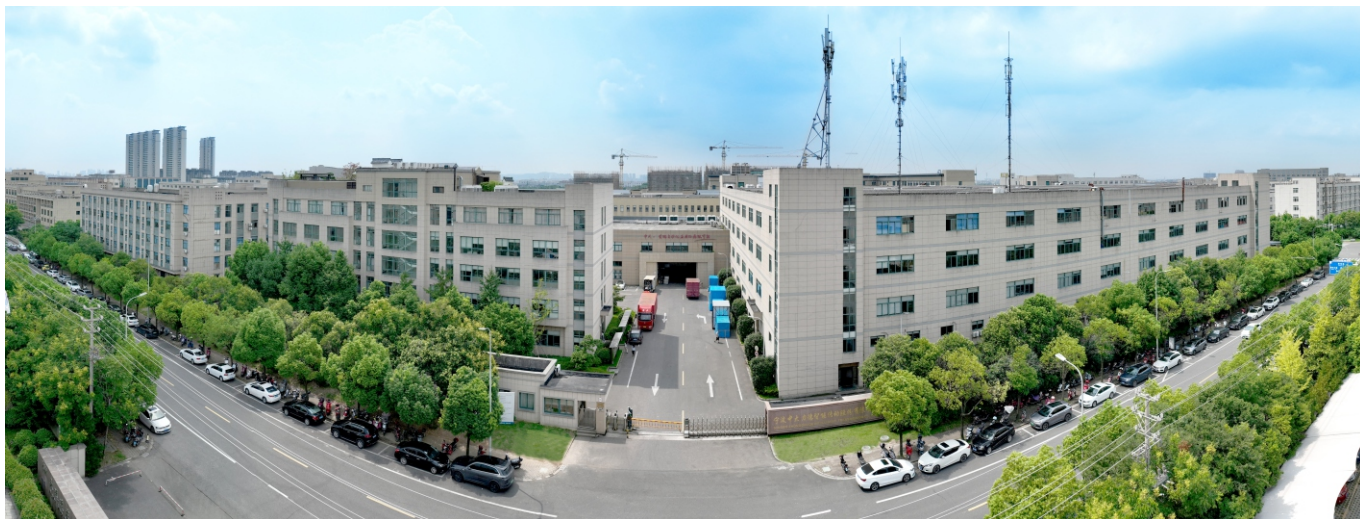
▲ บริษัท Ningbo Zhongda Leader Intelligent Transmission Co., Ltd. (สำนักงานใหญ่ประเทศจีน)
