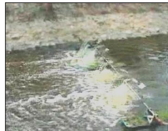
บ่อให้อากาศ2+น้ำจุลินทรีย์
