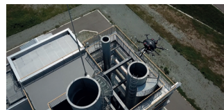
ドーワテクノスのドローン事業による点検・飛行サービス
