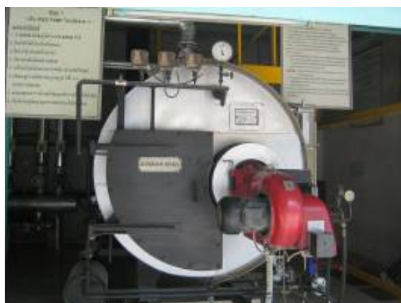
รูปที่ 6-5 หม้อน้ำเครื่องที่ 2 อัตราการผลิตไอน้ำ 2,000 kg/hr
