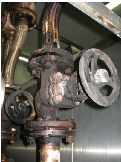
รูปที่ 6-25 การรั่วของของเหลวที่ใช้เป็นสื่อนำความร้อนที่บริเวณข้อต่อวาล์ว
