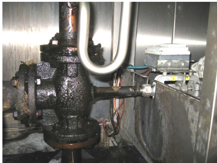
รูปที่ 6-25 การรั่วของของเหลวที่ใช้เป็นสื่อนำความร้อนที่บริเวณข้อต่อวาล์ว
