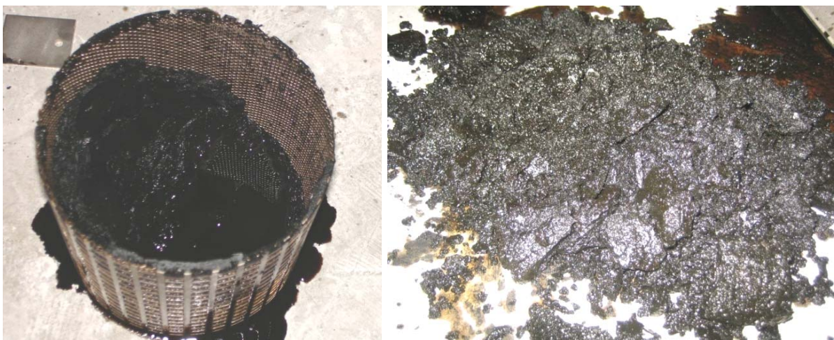
รูปที่ 6-28 ตะกอนที่เกิดจากของเหลวที่ใช้เป็นสื่อนำความร้อนเสื่อมสภาพและสกปรก
