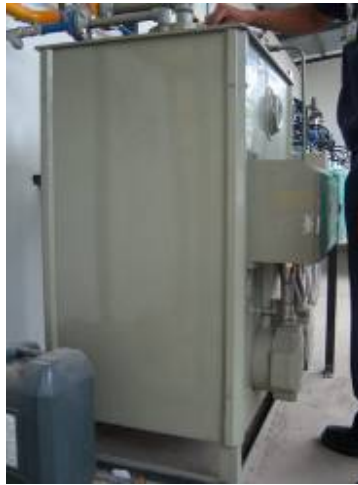
รูปที่ 6-18 เครื่องอุ่นเชื้อเพลิงแบบใช้ไฟฟ้า
