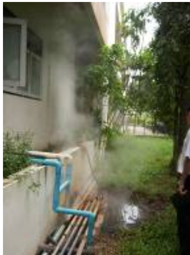
รูปที่ 6-11 การปล่อยทิ้งไอน้ำก่อนการปรับปรุง
