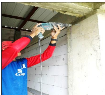
5. เจาะระยะเสียบเหล็กให้ตรงกับเหล็กยื่น สมาร์ท ลินเทล
