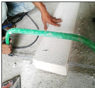
2. ตัดปลาย สมาร์ท ลินเทล จนถึงเหล็ก เอาเนื้อมวลเบาออก
