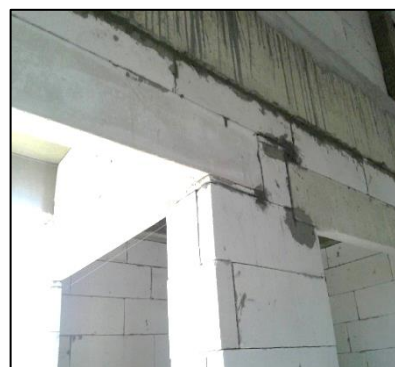
8. ป้ายปูนเก็บรายละเอียดตรงรอยต่อเพื่อเพิ่มความแข็งแรง
