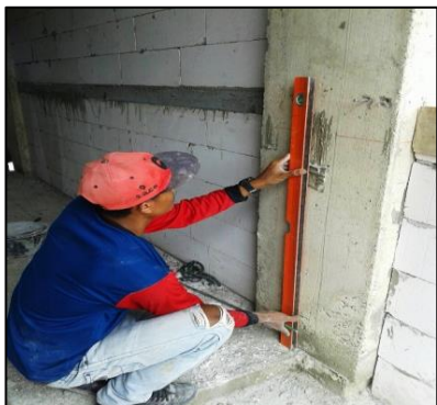
1. หาแนวระดับเส้นตั้ง เส้นฉาก และตำแหน่งที่จะวางสมาร์ท ลินเทล
