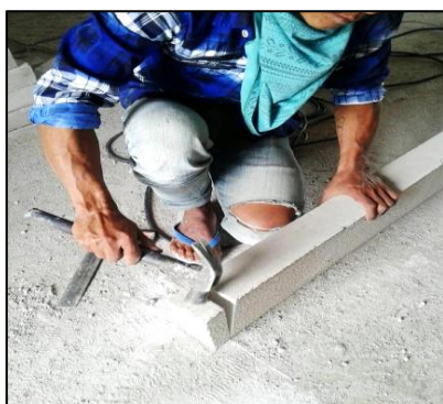
3. ทำการตัดปลาย สมาร์ท ลินเทลออก
