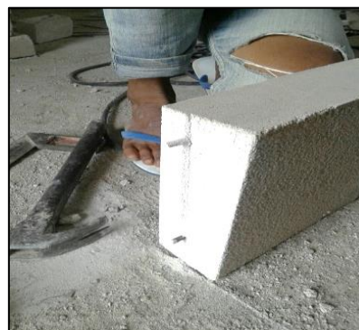
4. ตัดให้เห็นเหล็กยื่นไม่น้อยกว่า 5 ซม. เพื่อเป็นระยะทาบ
