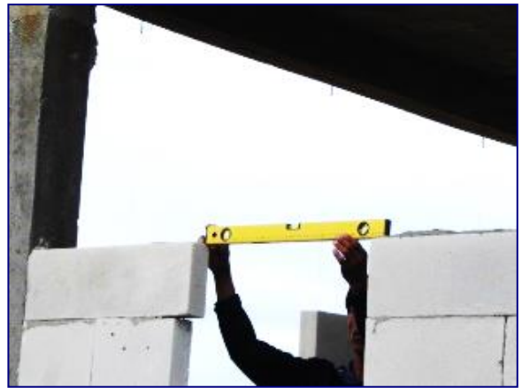
2. เช็คระดับก่อนวาง สมาร์ท ลินเทล
