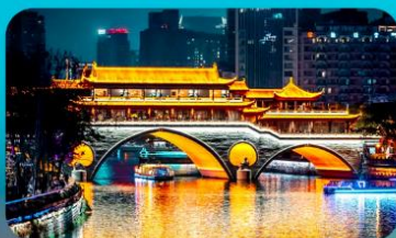
สะพานอันชุน
