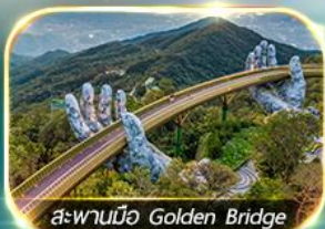
สะพานมือ Golden Bridge
