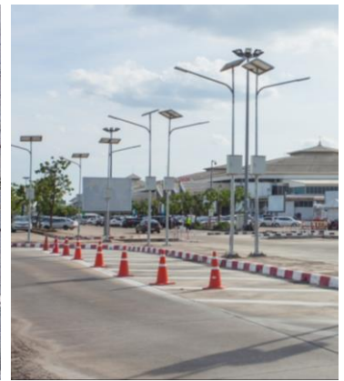
เพิ่มที่จอดรถยนต์ อีกไม่น้อยกว่า 1,600 คัน
