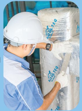
4 สำหรับรอยต่อของแผ่นฉนวนให้ปิดทับด้วย อลูมิเนียมเทปฟอยล์ Sealing gaps or joints with aluminum foil tape.
