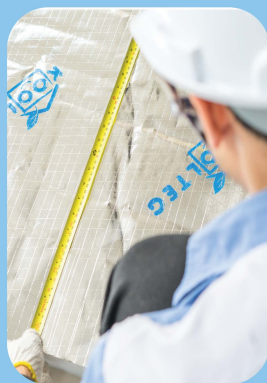
2 ตัดฉนวนฯ ให้พอดีกับขนาดของท่อ โดยให้มีระยะซ้อนทับกับขงฉนวนอย่างน้อย 5 ซม. Cutting the insulation refer to size of duct.
