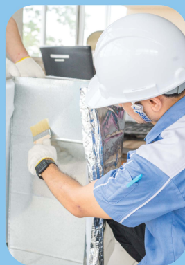
3 ติดตั้งฉนวนให้ใช้ Spindle Pin ยึดติดตัวฉนวนกับท่อ Installing insulation to pipes with glue and fasten with stainless steel wire
