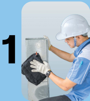
1 ทำสะอาดพื้นผิวของท่อลมให้สะอาด Cleaning the surface of duct.
