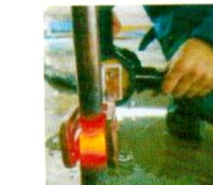
大铜管、钢管加热焊接
