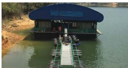
โครงการปรับปรุงระบบน้ำดิบ (ระยะเร่งด่วน) กปภ.สาขาระนอง จ.ระนอง
