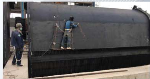
โครงการเพิ่มประสิทธิภาพสถานีสูบน้ำท่าฉางวัง จ.สมุทรสาคร
