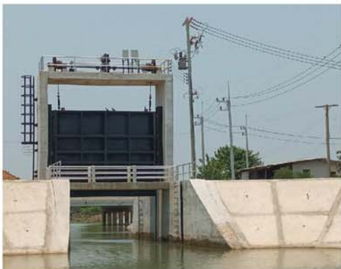
โครงการก่อสร้างคันกันน้ำฝั่งซ้ายคลองระบายน้ำใหญ่สองพี่น้อง พร้อมอาคารประกอบ จังหวัดสุพรรณบุรี
