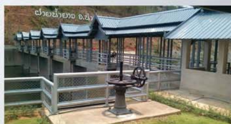
โครงการก่อสร้างฝายน้ำยาวพร้อมระบบส่งน้ำ จ.น่าน
