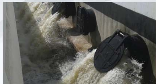
โครงการก่อสร้างประตูระบายน้ำคลองระบายน้ำ D8 (ห้วยพระเคือ) ระยะที่ 2 จ.ขอนแก่น
