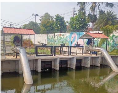
โครงการก่อสร้างประตูน้ำ พร้อมเครื่องสูบน้ำ บริเวณปากซอยกระทุ่มล้ม ๑๐
