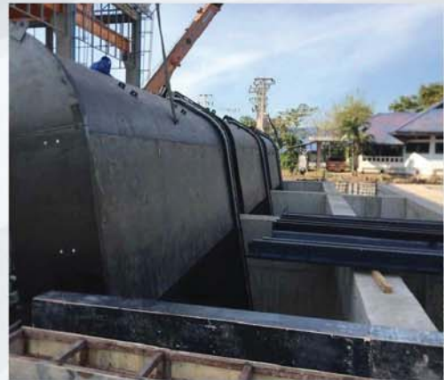
โครงการเพิ่มประสิทธิภาพสถานีสูบน้ำท่าฉางวัง จ.สมุทรสาคร
