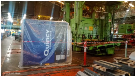
ภาพการติดตั้ง New Air Compressor QUINCY Model QGDV 75 PLUS
