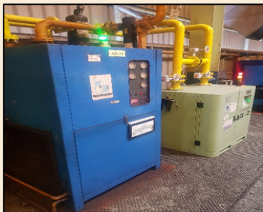
ก่อนการปรับปรุง Air Dryer AD-11 "HANKISON" 80500
