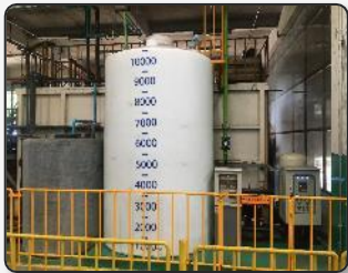
1. น้ำสำหรับทดสอบรอยรั่วของชิ้นงานและน้ำล้างในห้องน้ำ
