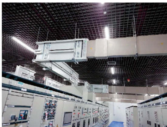
รูปที่ 3.22 ตัวอย่างการติดตั้งใช้งานบัสเวย์
