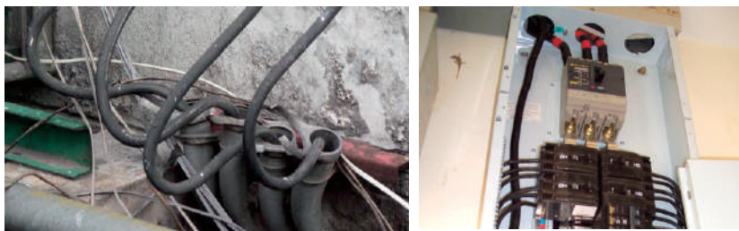
รูปที่ 3.4 การเดินสายที่เกิดความร้อนจากกระแสเหนี่ยวนำ (ตัวอย่างที่ดี)
