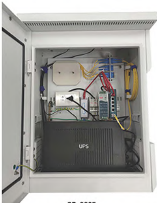
SP-2305 การติดตั้งอุปกรณ์ F.O. ในตู้ CCTV Cabinet (Outdoor) พร้อมจัดสาย
