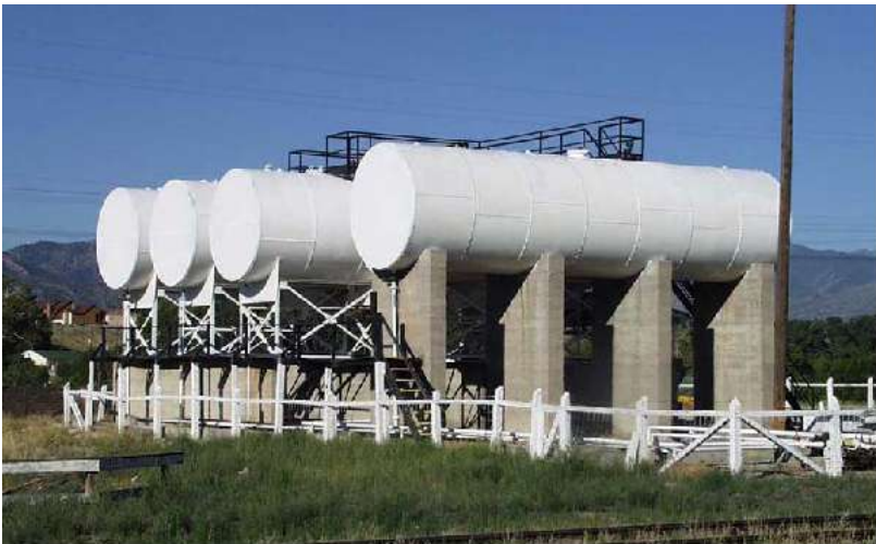
รูปที่ 2 แสดงถังเก็บเชื้อเพลิงเหลวแบบตั้งบนดิน
