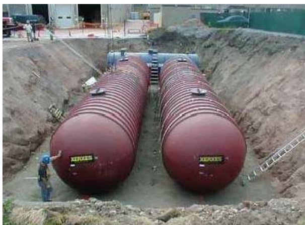
รูปที่ 1 แสดงการติดตั้งถังใต้ดิน
